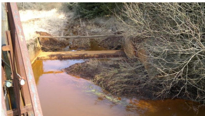
Fig. 5. Indløbsbygværket til dambruget er ca. 4 m bredt.
